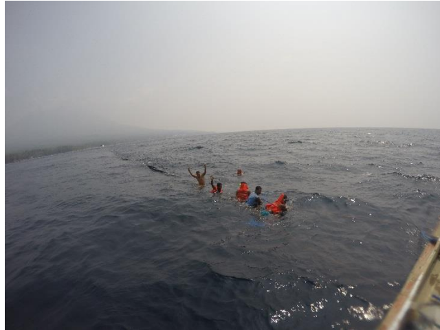
Gambar 6 Pemasangan di Laut
