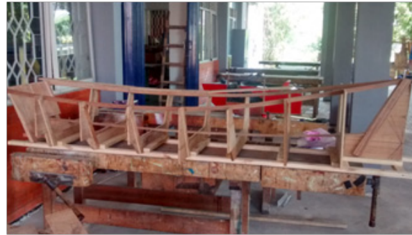
Gambar 4. Pembuatan rangka cetakan perahu
