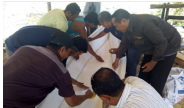
Gambar 5. Pelapisan Release Agent pada cetakan
