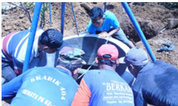
Gambar 10. Peletakkan beton buis untuk digister di desa Kendal, Ngawi Sumber : Dokumentasi Pelaksanaan, 2018
