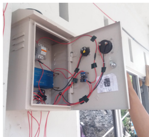
Gambar 3. Dokumentasi pemasangan panel hubung
